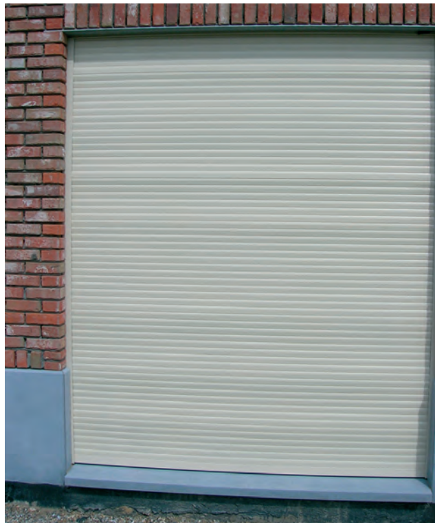
Bild 4 Welligkeit von Rollladenpanzern
